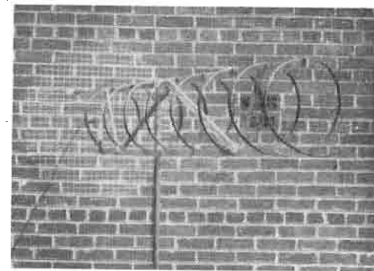
Antenna elicoidale a 8 spire isolata in vetro pressato.
